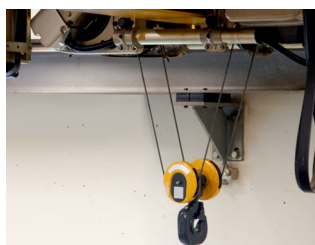
MAXUM Auflager für Stahlkonstruktionen und Kranbahnen
