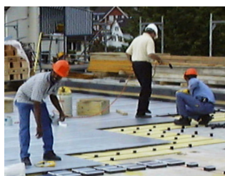
Verlegearbeiten Gebäude-lagerung mit MAXUM Auflager
